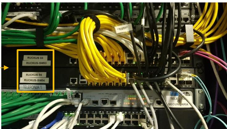
por patios e instalaciones deportivas, es necesario una alta velocidad de interconexión mediante Fibras redundantes. **Fueron necesarios 3 switches ICX7150 de 24 puertos PoE y uno más pequeño de 12 puertos para un edificio anexo,** para sustituir la tecnología anterior de CISCO y dar servicio
